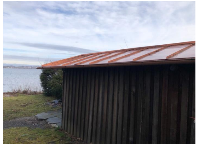
f) Beispielaufnahme eines Nebengebäudes mit potenzieller Eignung für Fledermäuse, "Wörthseeufer Süd"
