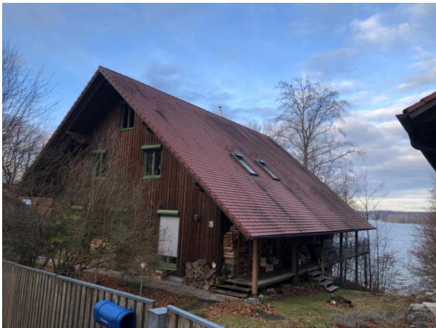
e) Beispielaufnahme eines Gebäudes Gebäude mit guter Habitategnung für Fledermäuse, "Wörthseeufer Nord"
